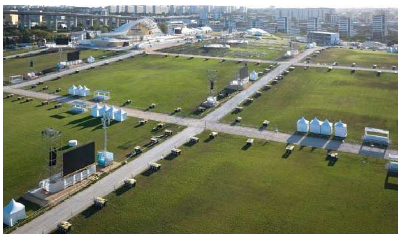
19 – Imagem geral dos equipamentos do recinto
