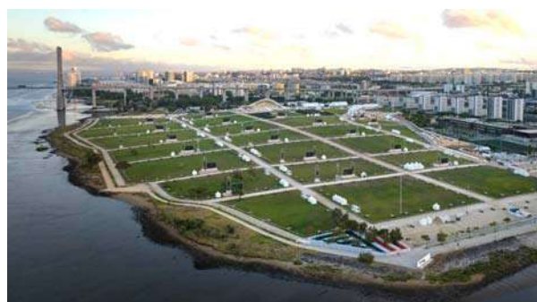
22 – Vista aérea do recinto (sentido sudoeste)
