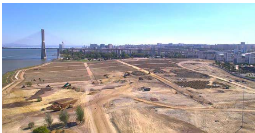
6 – Fotografia aérea do recinto durante os trabalhos de modelação
