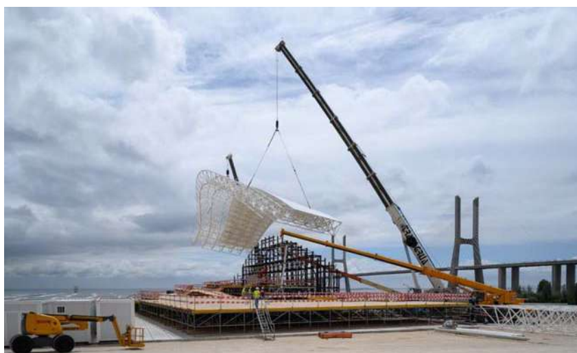
13 – Operação de montagem da cobertura do Altar-Palco
