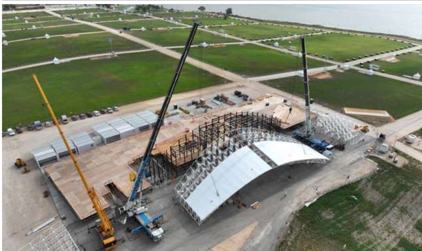
12 – Operação de montagem da cobertura do Altar-Palco
