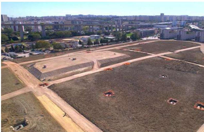
5 – Fotografia aérea do aterro provisório de pré-carga na zona do Altar-Palco
