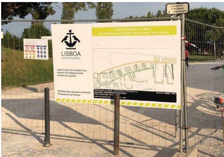
Obra de substituição do pavimento no Passeio dos Heróis do Mar, no Parque das Nações
