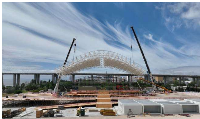
14 – Operação de montagem da cobertura do Altar-Palco
